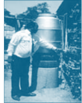
Vue extérieure d'un réservoir au sol
