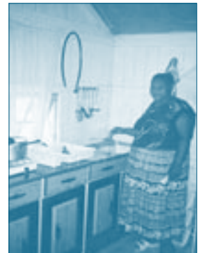
Vue intérieure d'une nouvelle installation
